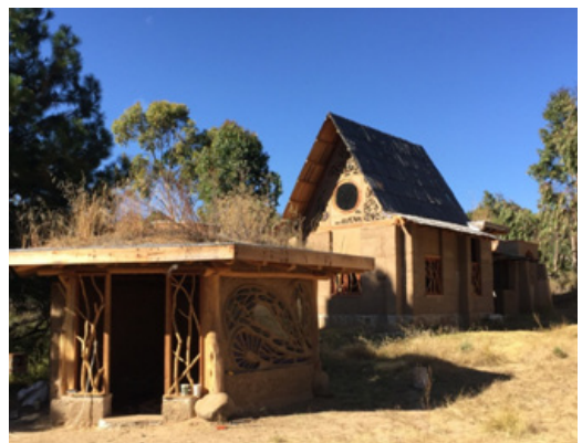
Figura 6. Parte de las instalaciones del Proyecto San Isidro en Tlaxco, Tlaxcala.
