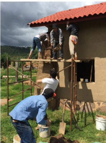
De izquierda a derecha: Figura 9. "Cadena humana" para el lanzamiento de esferas de tierra amasada. Figura 10. Terminación del revocado de tierra con llanas metálicas. Figura 11. Estructura de pajarcilla para un vitral de botellas recicladas.
