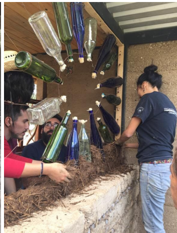
De izquierda a derecha: Figura 9. "Cadena humana" para el lanzamiento de esferas de tierra amasada. Figura 10. Terminación del revocado de tierra con llanas metálicas. Figura 11. Estructura de pajarcilla para un vitral de botellas recicladas.
