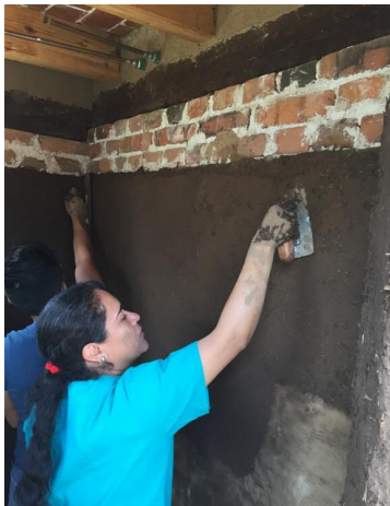
De izquierda a derecha: Figura 9. "Cadena humana" para el lanzamiento de esferas de tierra amasada. Figura 10. Terminación del revocado de tierra con llanas metálicas. Figura 11. Estructura de pajarcilla para un vitral de botellas recicladas.
